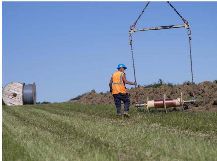
Les éoliennes des différents parcs en construction sont reliées par un réseau de câbles souterrains permettant de convoyer l'énergie produite jusqu'aux postes de livraison. (Ph. Stéphane Monnet)
