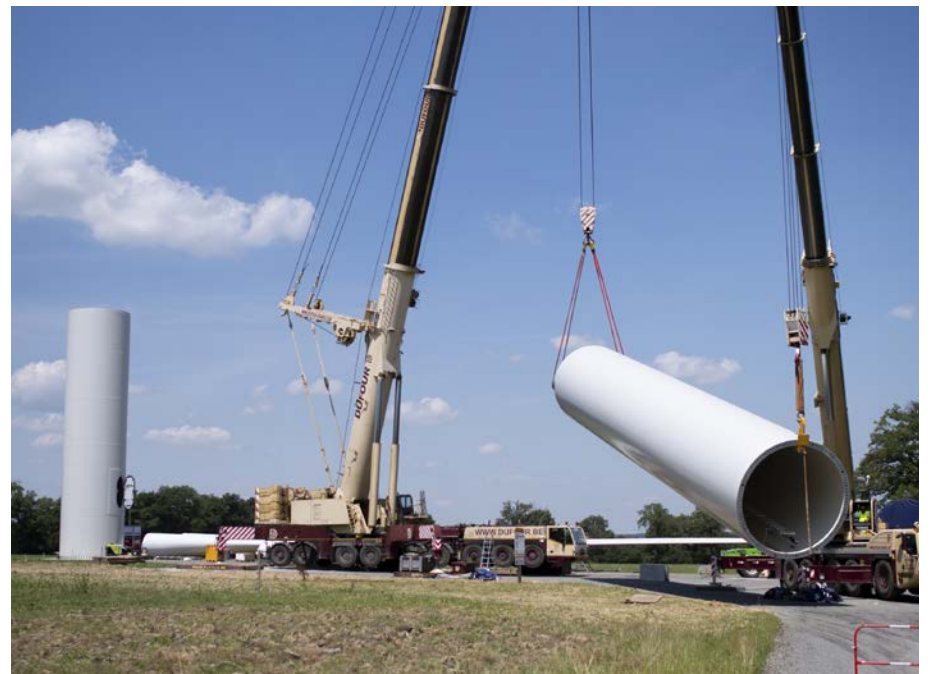
Après l'élément bottom (bas en anglais) boulonné sur la fondation (à gauche), les grues redressent le second élément du mât de l'éolienne de 95 m qui en compte quatre. (Ph. Stéphane Monnet)
